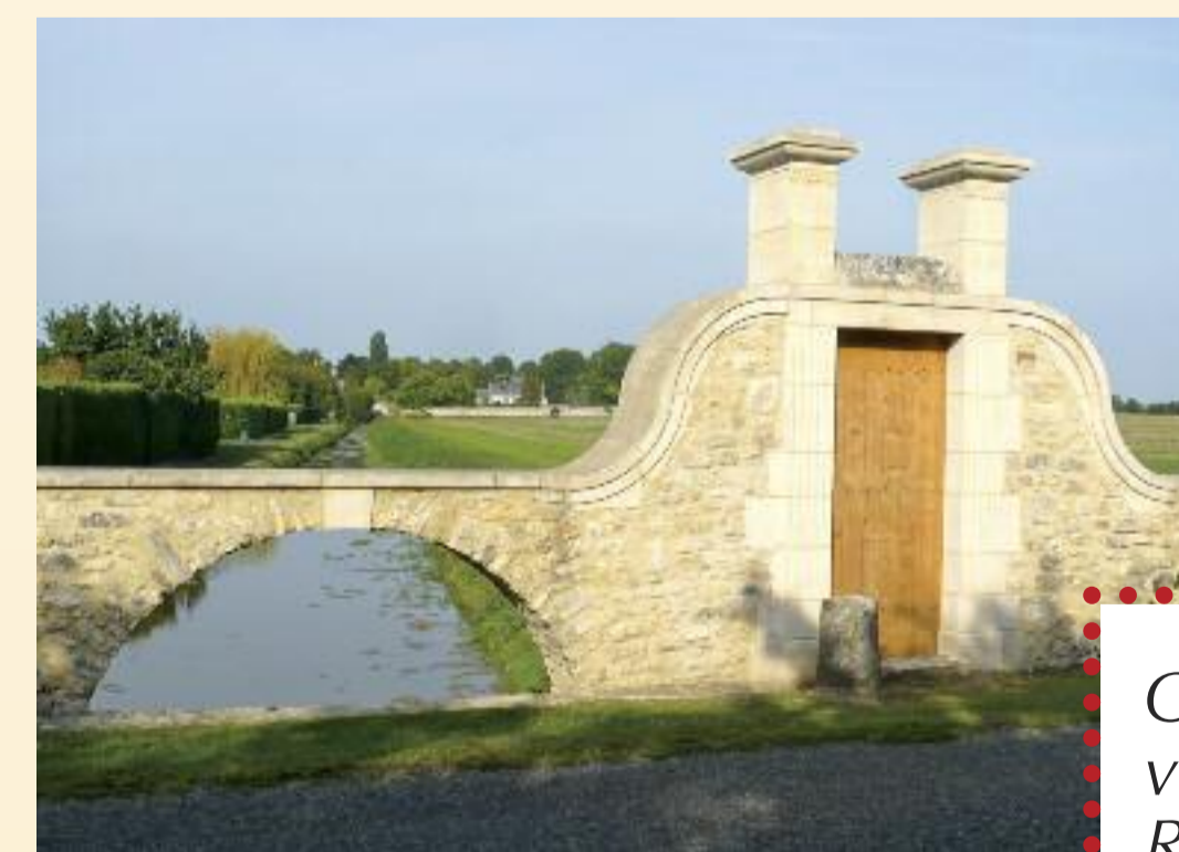
Porte-Pont du Moulinet
